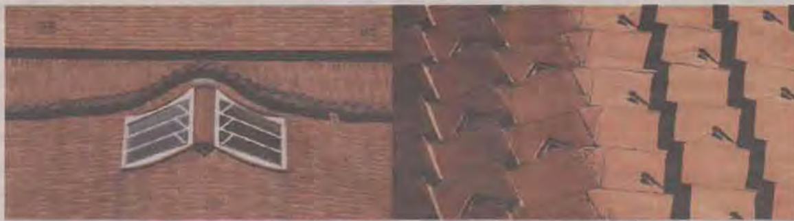
Glooiende vormen van baksteen in de gevels. Elk bouwonderdeel apart ontworpen.
