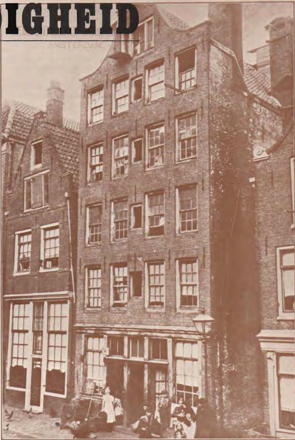
WILLEMSTRAAT 126 EN 150 BIJ DEN VERWERSGANG, GESLOOPT IN 1898.
